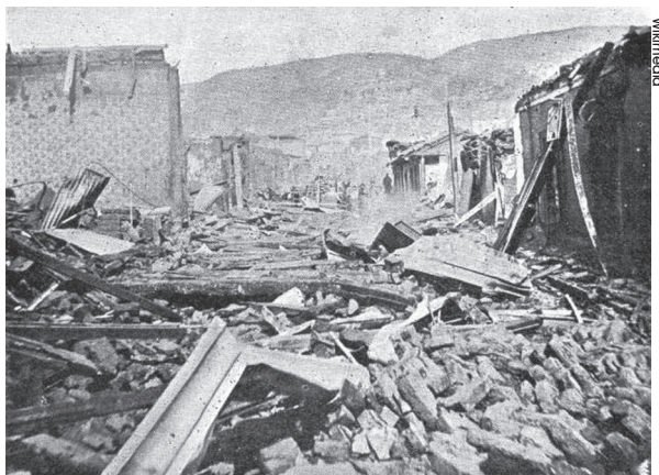
Daños provocados por los sismos
